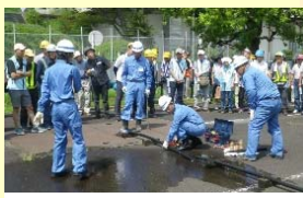
応急復旧訓練
